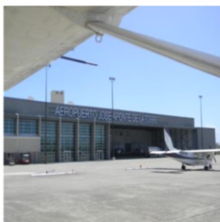
Aeropuerto regional José Aponte de la Torre de Ceiba, Foto Cybernews
